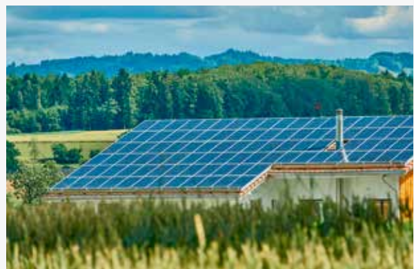
Photo : installation de SolarX.
