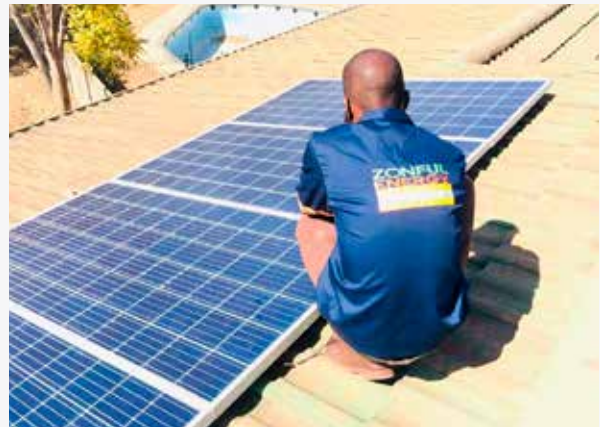
Photo : Zonful ; installation de panneaux solaires.
