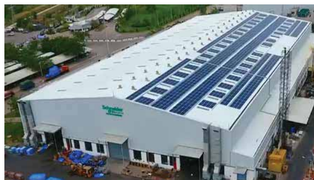
L'usine MVI & TBI de Schneider Electric en Inde génère environ 1 GWh par an d'énergie solaire sur site
